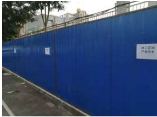
设置施工围挡
