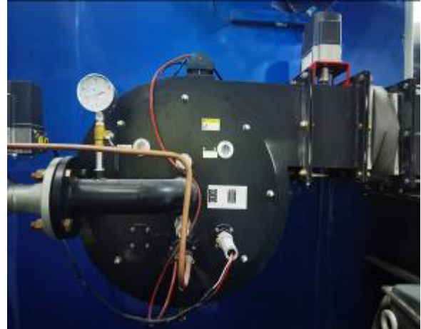
强制混合式低氮燃烧器
