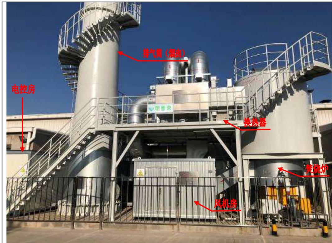
图7 本项目废气处理装置
