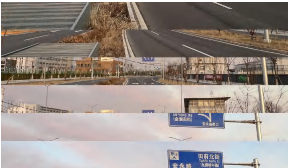
道路横断面现状照片
