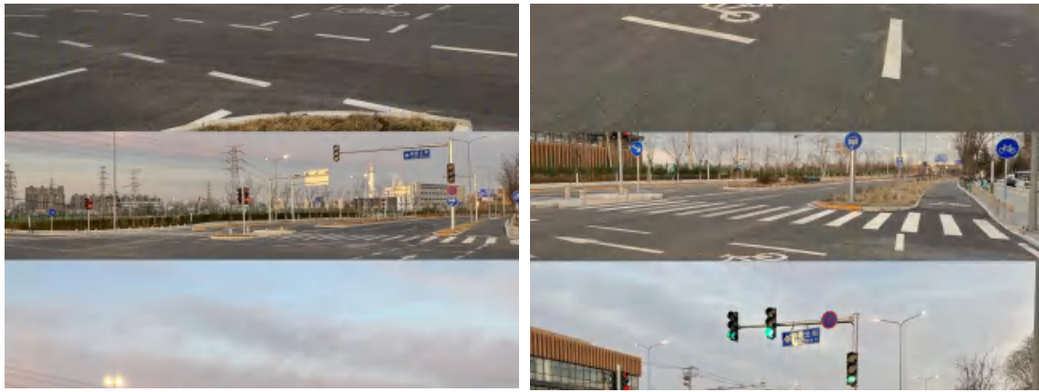
图 3 交通标线、交通标牌、信号灯等照片
