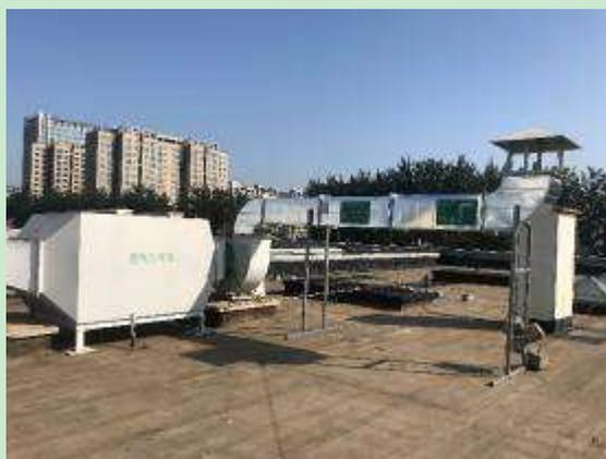
图6 噪声防治设施（基础减振）现状照片
