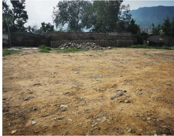
维修场所西侧现状
