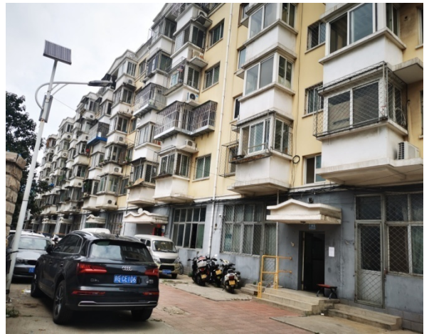
增峪路5号院居民楼（背路一侧）
