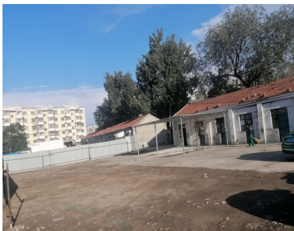
维修场所现状
