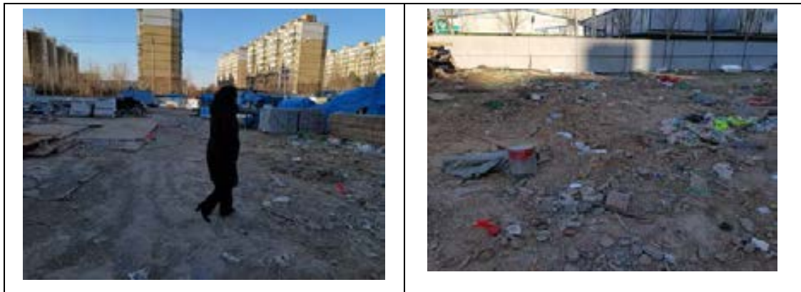
图8 项目场地现状照片
