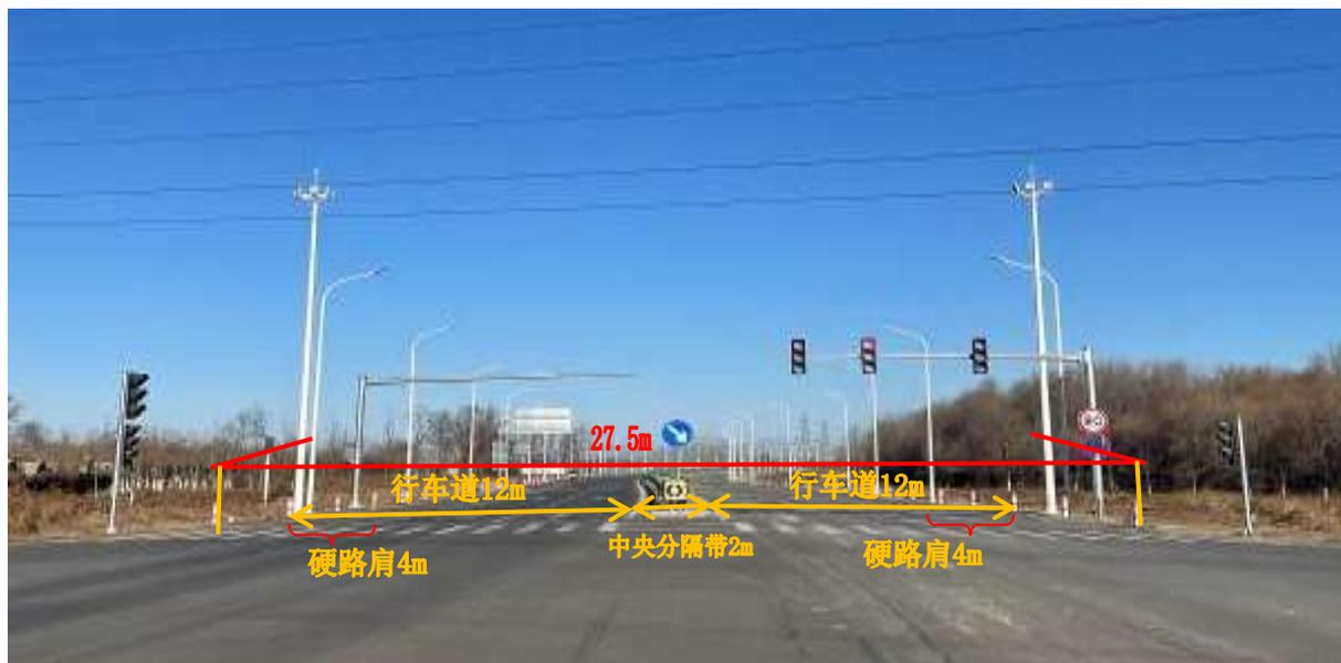
图 2-4 道路横断面实际布置图（K1+756~K8+730）
