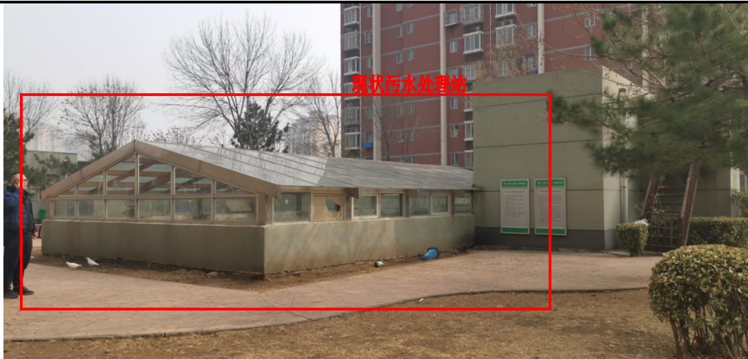
图 5 集水池与污水处理站现状照片
