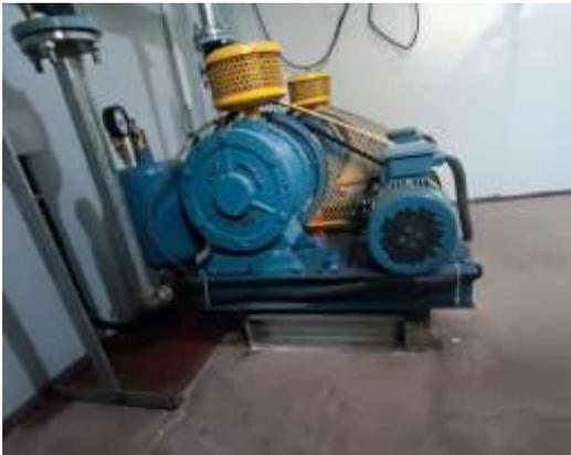
低噪声回旋式鼓风机（含底部基础减振）
