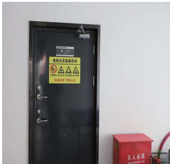
危险化学品库外部
