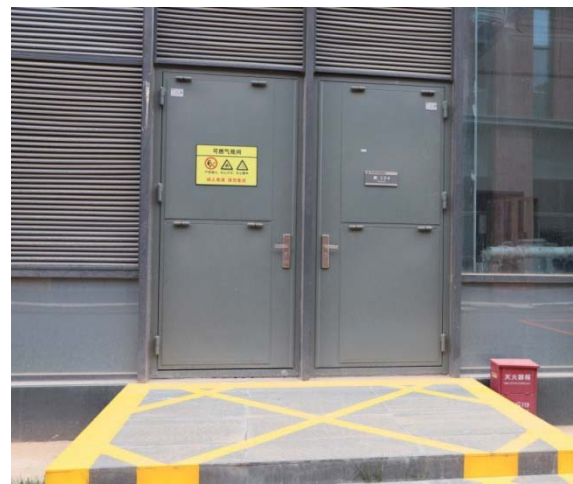
可燃气瓶间外部
