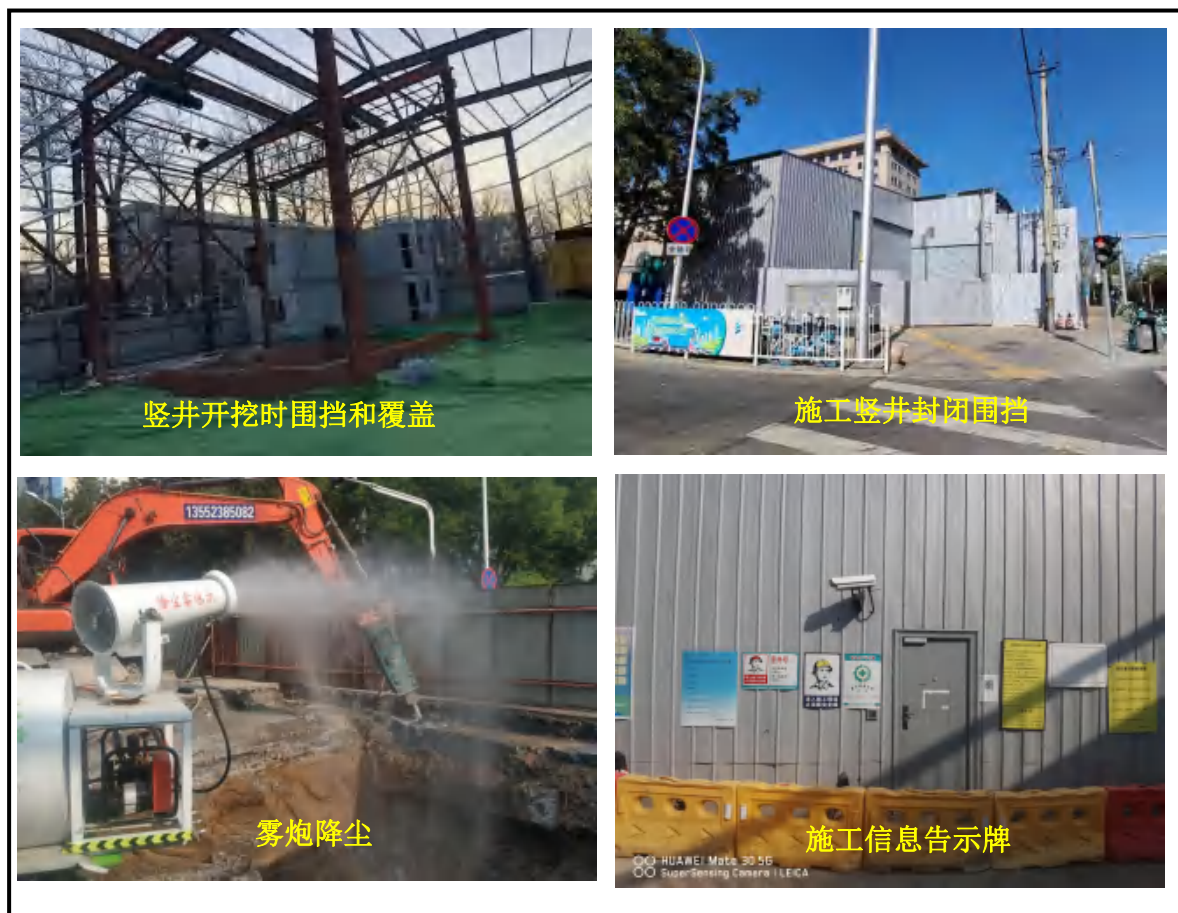
图 7 项目施工期大气污染防治措施照片
