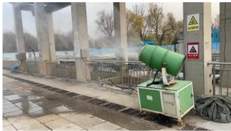
除臭试剂雾化
