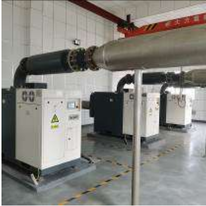
室内墙体隔声、消音器、基础减振
