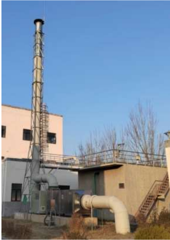
恶臭废气排气筒 DA001 排放口、监测点位标识牌及监测平台
