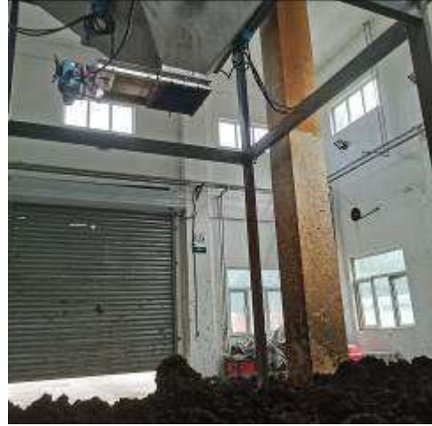
污泥脱水间密闭
