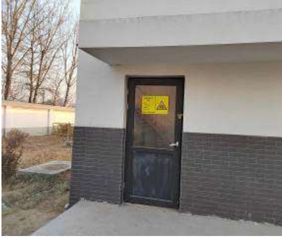
危险废物暂存间
