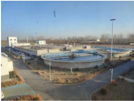
污水处理设施
