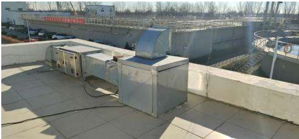
静电式油烟净化器+6m 高排气筒 DA002
