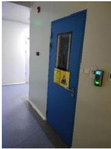
4 幢危险废物暂存间
