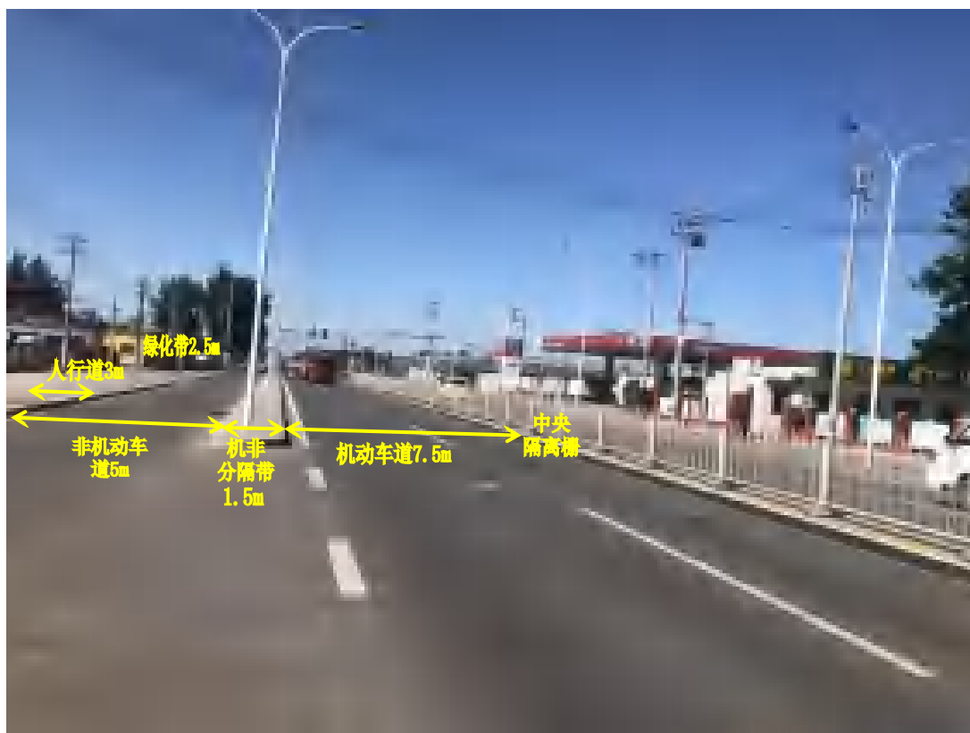
图 2-7 村镇段道路横断面实际布设图
