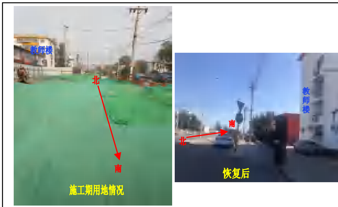
图 5-6 施工期间用地内情况及恢复后对比照片
