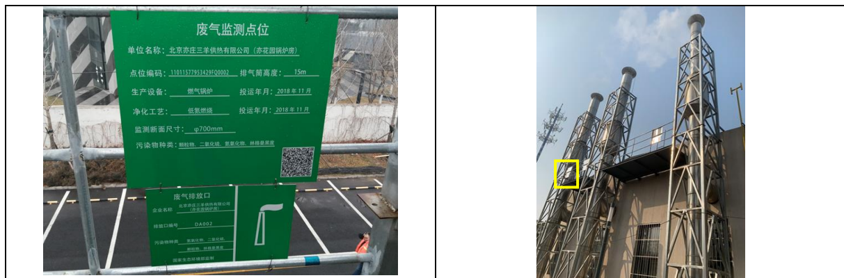
图 3-5 DA002 环保图形标志牌及监测点位标志牌 (黄框位置)
