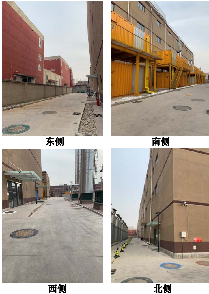
图1 项目3号楼建筑四至现状照片
