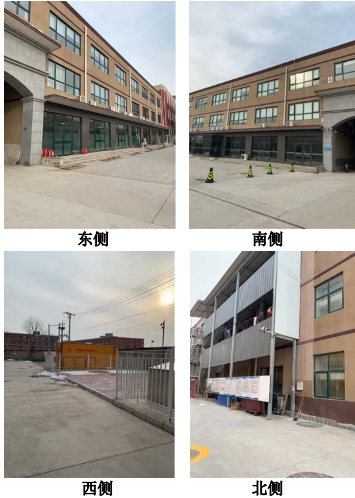
图 2 项目 4 号楼建筑四至现状照片
