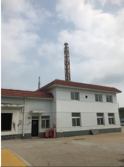
粪便消纳处理车间恶臭废气排气筒 DA001
