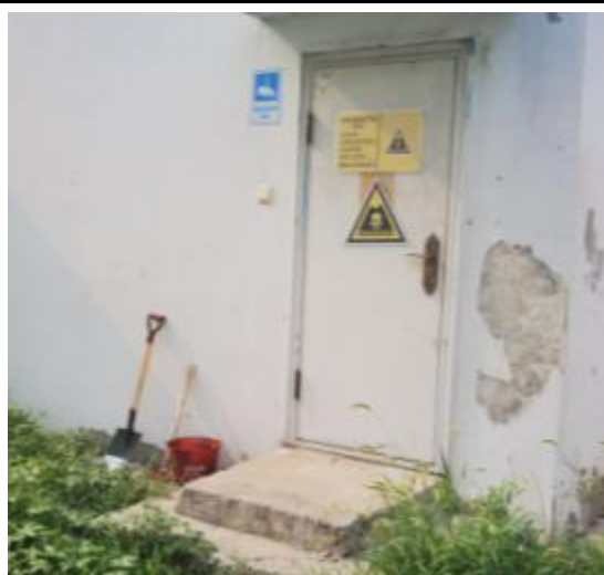
危废暂存间外部
