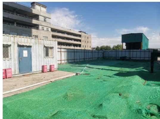
施工围挡、封闭罩棚
