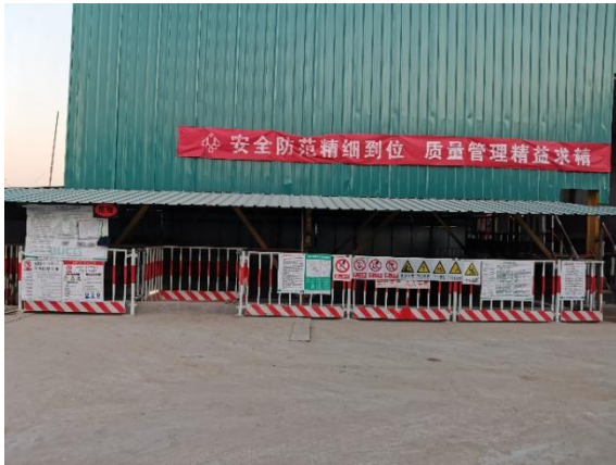
施工围挡、封闭罩棚
