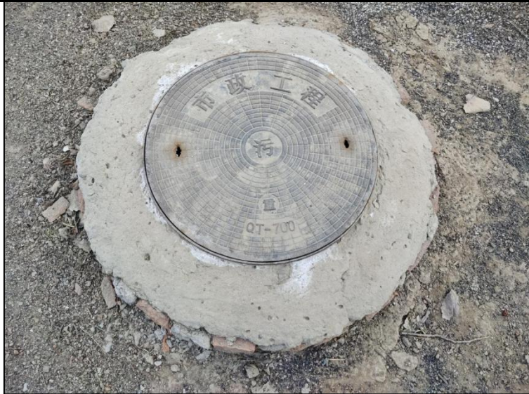
图 16 本项目化粪池现状照片
