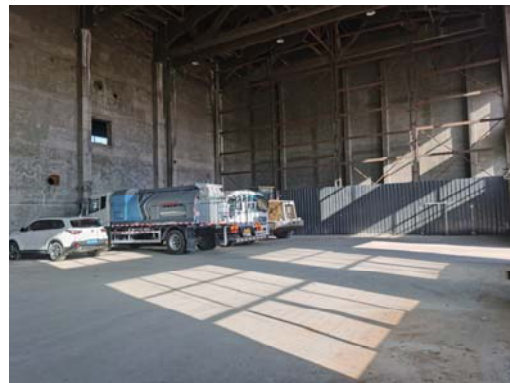
本次新增锅炉利用现有锅炉房西侧闲置区域
