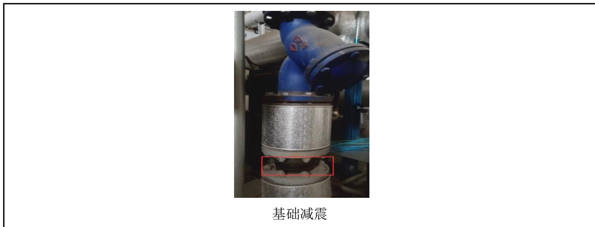
图 4 噪声防治设施现状照片
