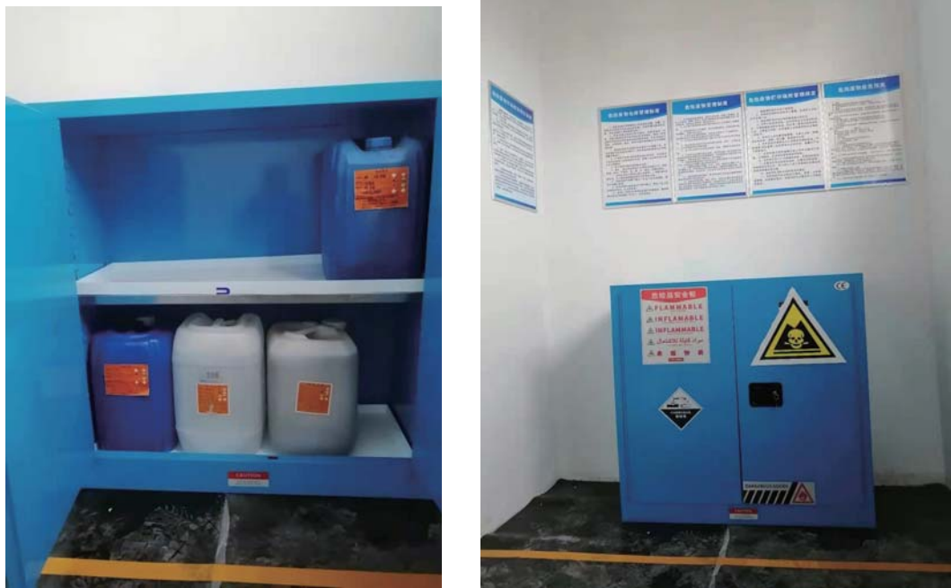
图3-7 危险废物暂存柜及危险废物管理制度
