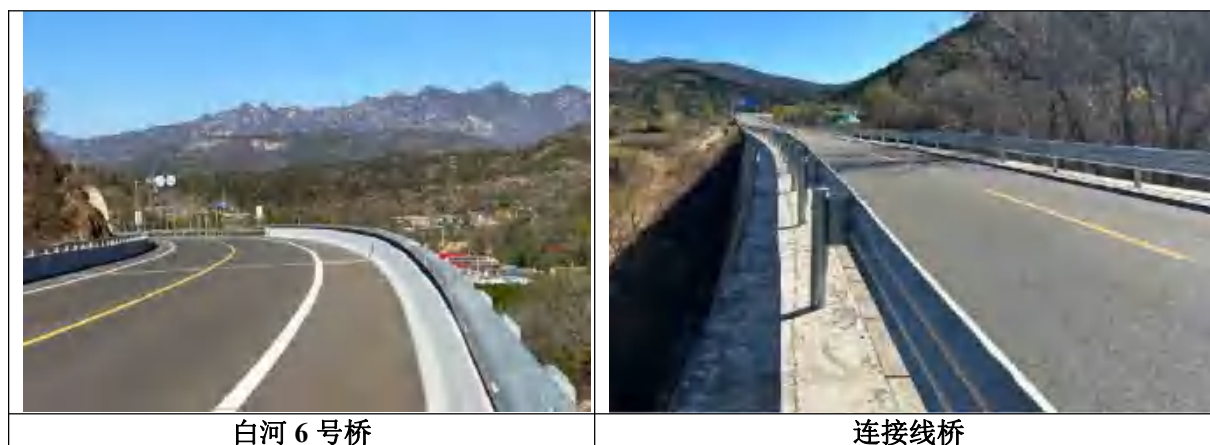
图 2-7 本项目主要桥梁现状照片
