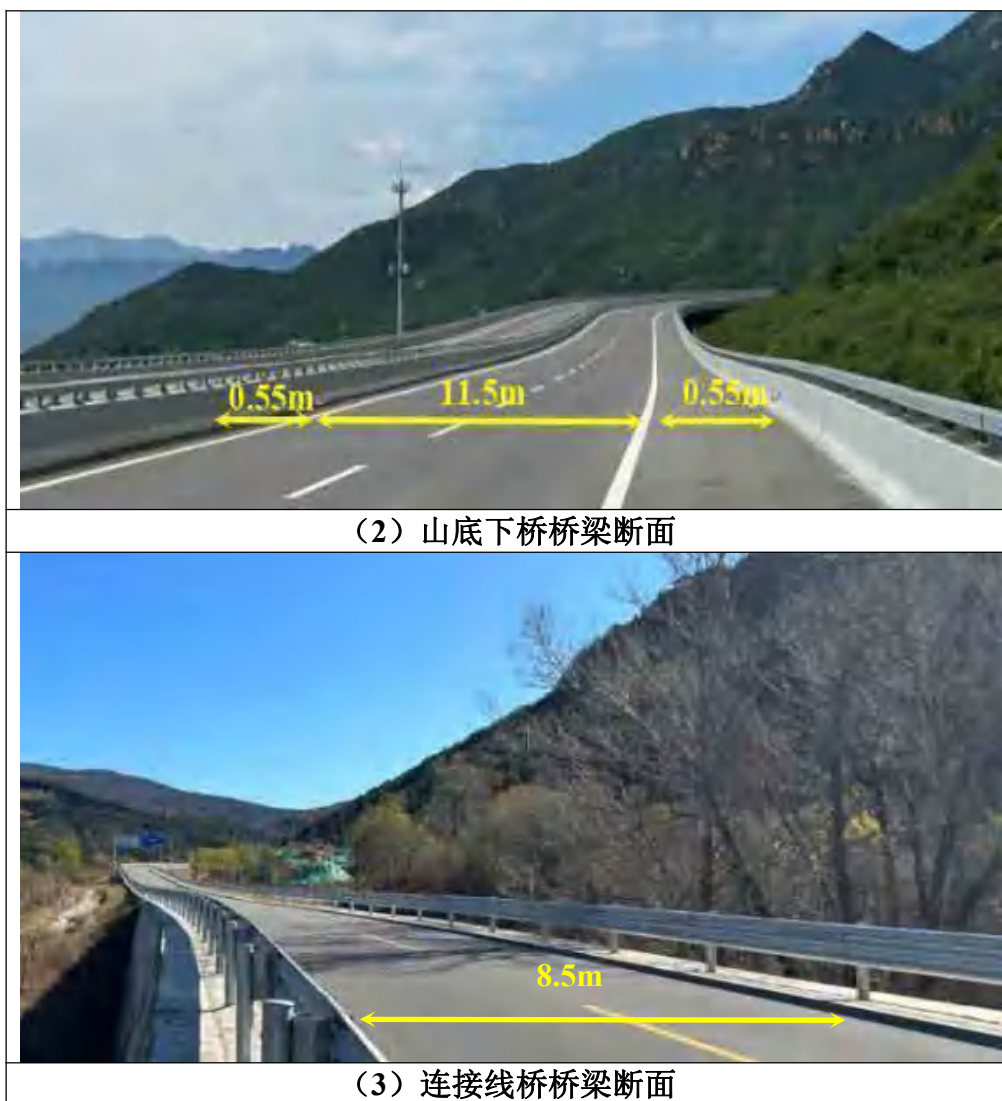
图 2-3 实际建设桥梁标准横断面图
