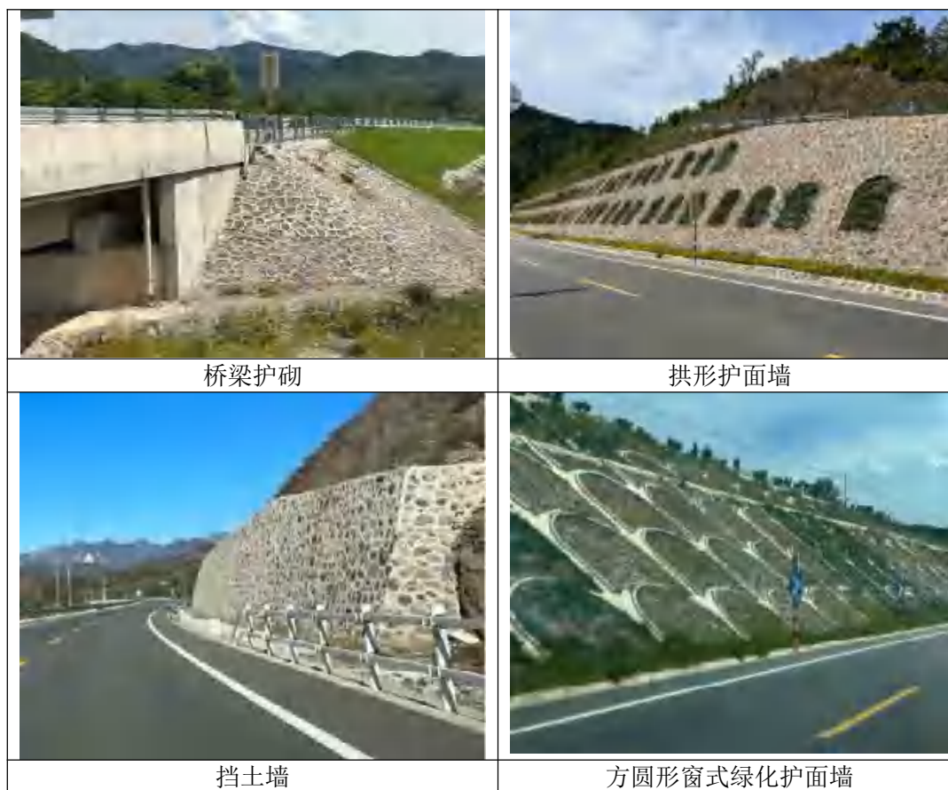
图 5-6 本项目主要水土保持措施
