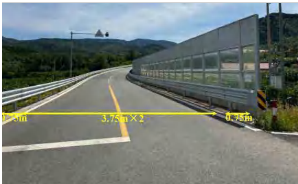
图 2-4 连接线实际建设路基标准横断面图
