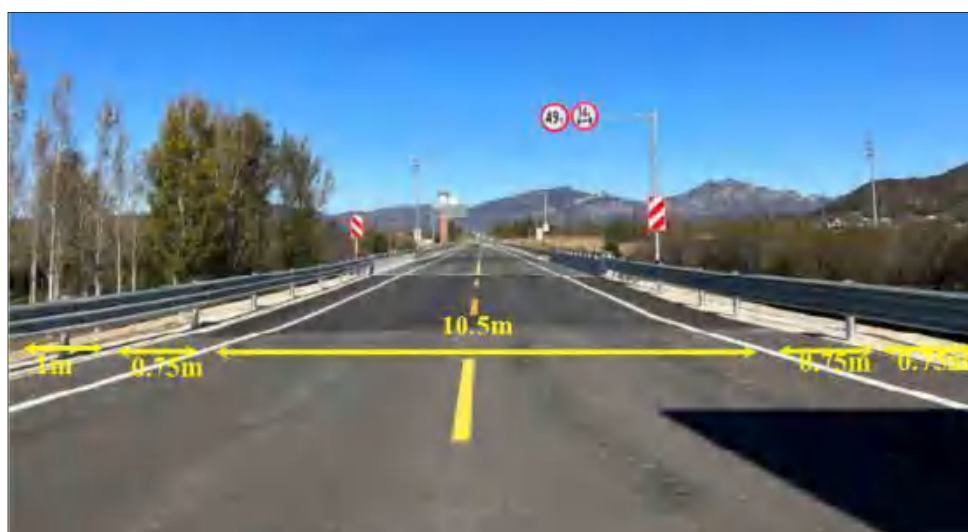
图 2-3 主路线实际建设路基标准横断面图
