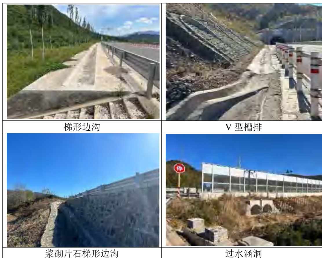
图 2-7 本项目主要排水工程现状照片
