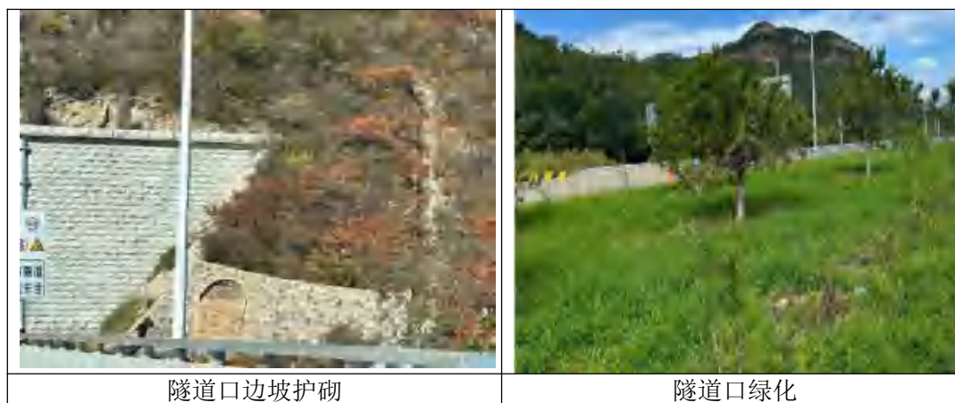
图 5-7 本项目隧道口生态防护工程
