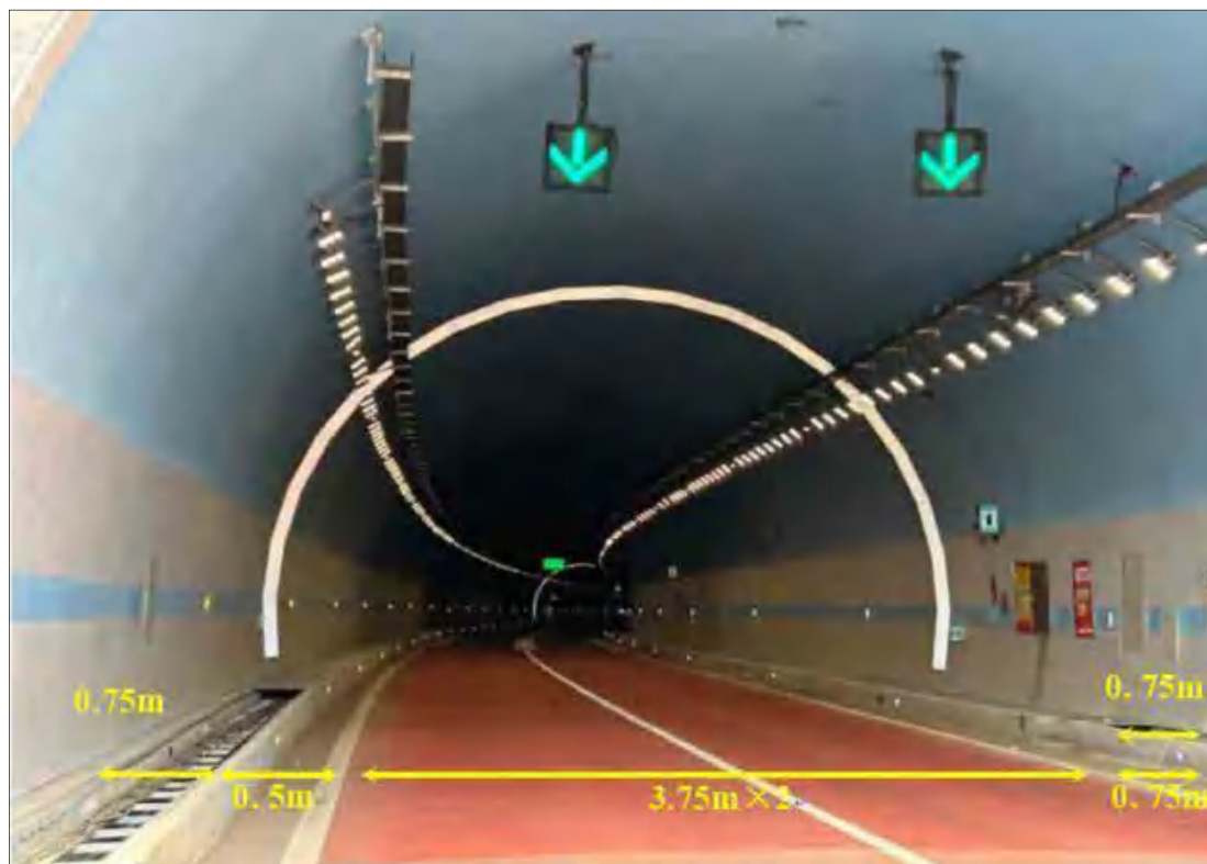
图 2-4 隧道段横断面实际布设图
